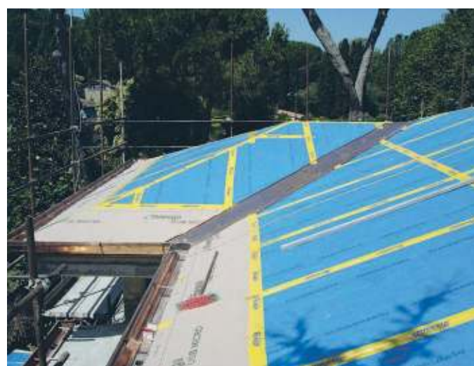
VILLINO AD ANGUILLARA SABINA CERTIFICATO CASA CLIMA GOLD ISOLAMENTO DELLA COPERTURA CON SISTEMA STIFERITE ISOVENTILATO
