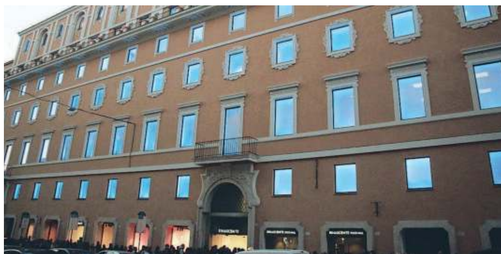
PER L'EFFICIENTAMENTO DELLA "RINASCENTE" DI VIA DEL TRITONE SONO STATI ADOTTATI I PANNELLI STIFERITE PER L'ISOLAMENTO TERMICO DELLE COPERTURE E DELLE PARETI CON SISTEMA A CAPPOTTO
